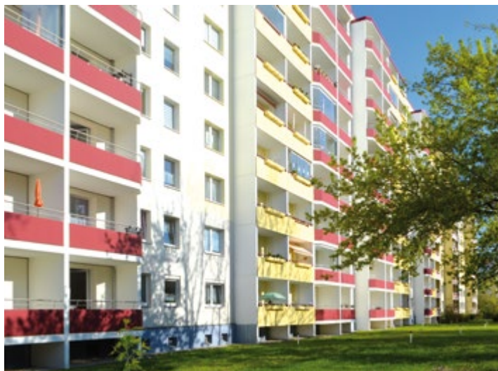
30 Erstmieter wohnen noch in der Marchwizastraße, wo im Juli 1977 die erste Grundsteinlegung gefeiert wurde.
